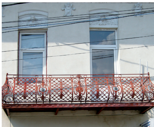
▲ GREȘIT: înlocuirea tâmplăriei istorice cu ferestre tip termopan în rame de pvc și aluminiu de culoare albă
