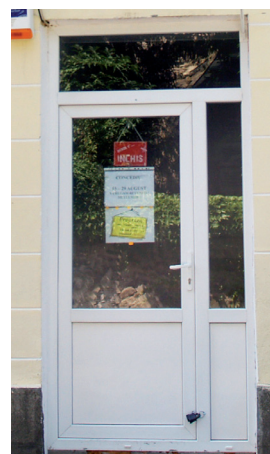
▲ GREȘIT: înlocuirea ușilor istorice cu uși tip termopan cu rame de culoare albă
