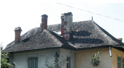
Acoperișuri tradiționale cu învelitoare din șită
